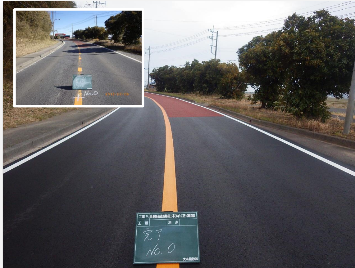
施工前後の路面状況 (No.0)
