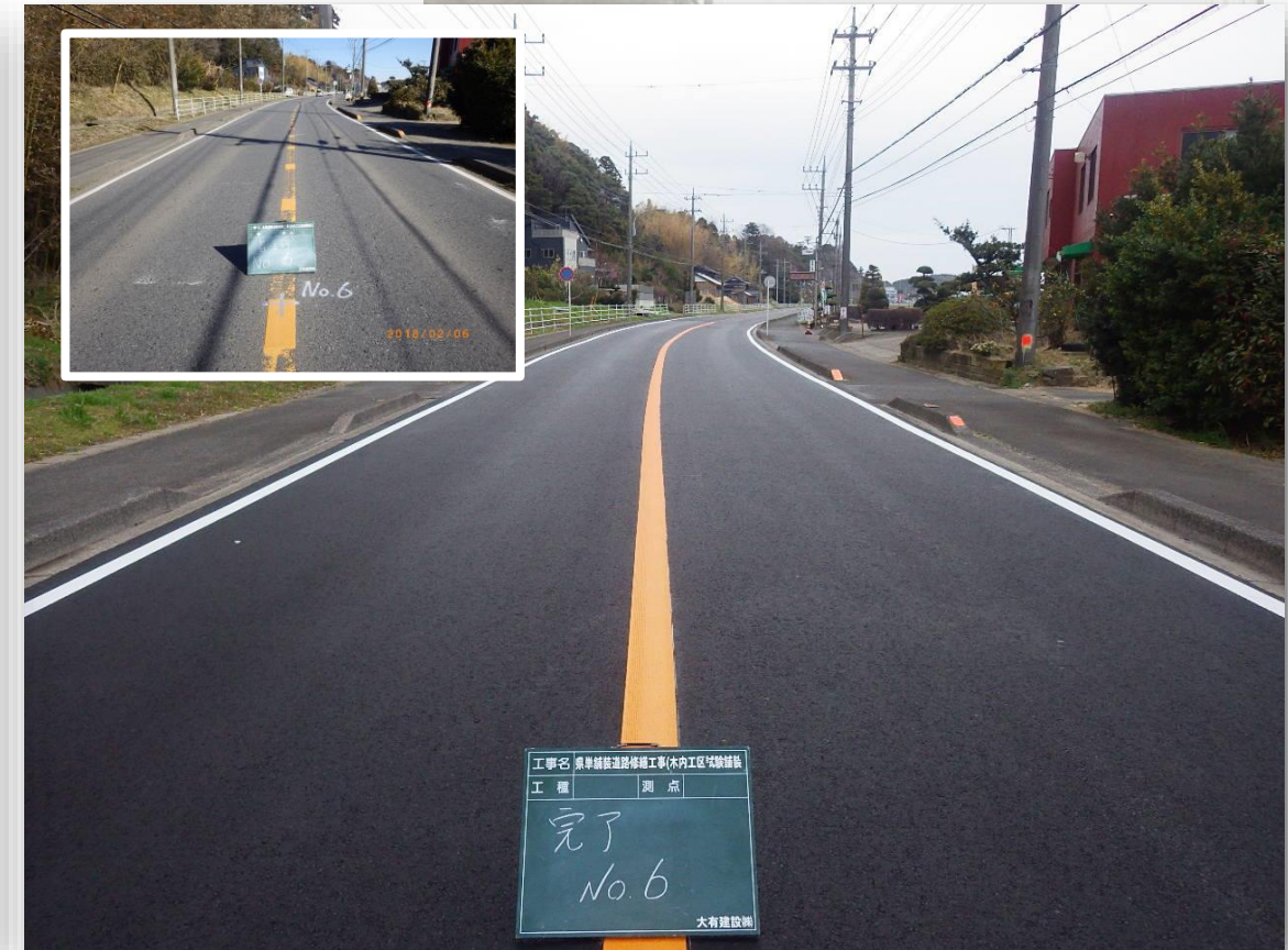
施工前後の路面状況 (No.6)
