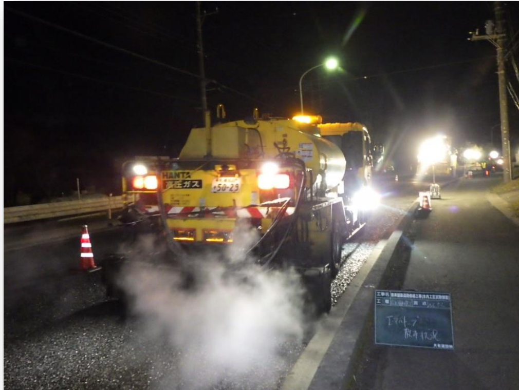
加圧デストリビュータによる 改質アスファルト乳剤（PKM-T）の散布
