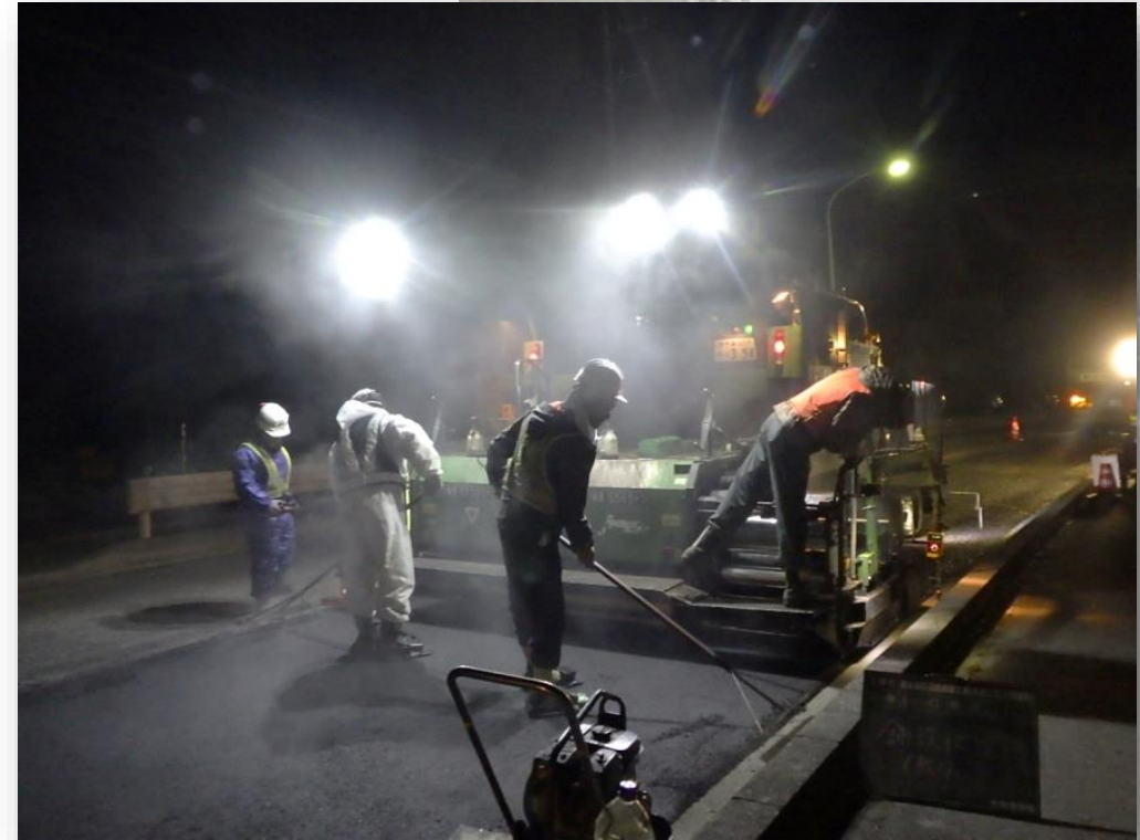
アスファルトフィニッシャによる クラック抑制型アスファルト混合物の敷均し
